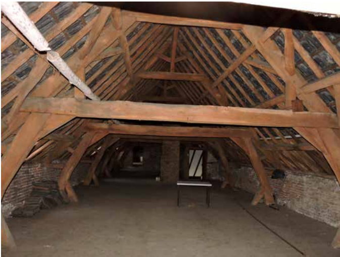
171. De zolder van west naar oost gezien met rechts de deur vanaf de trap vanuit de verdieping en op de achtergrond de opening naar de haakse vleugel
