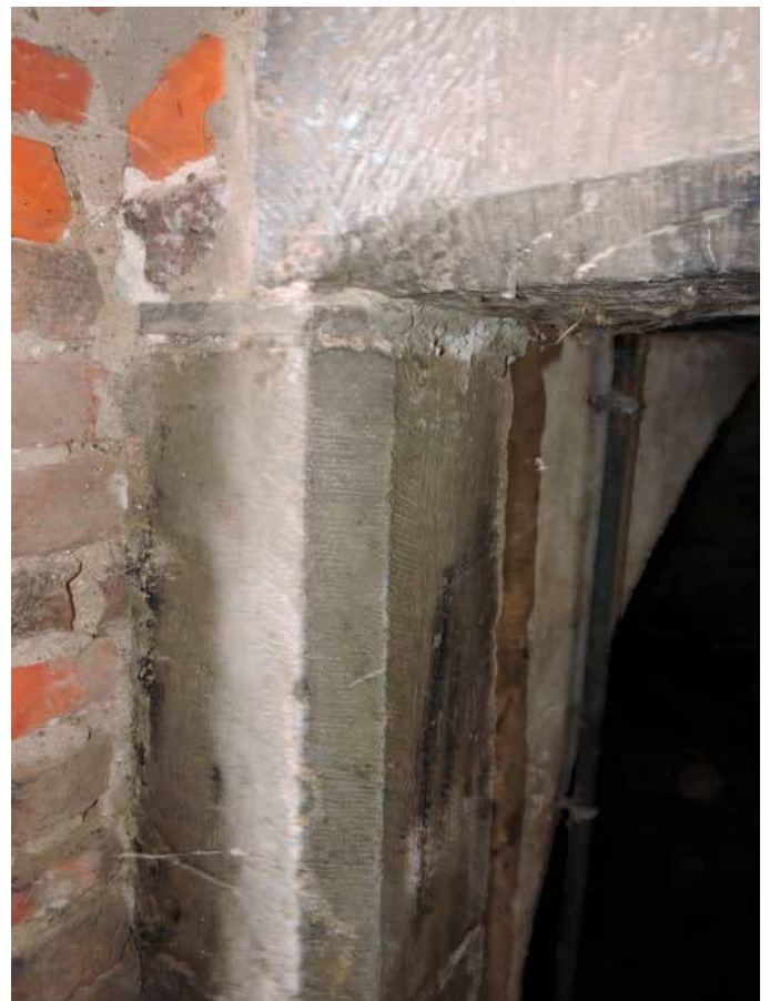
65. De deuromlijsting is een combinatie van Naamse steen en beton
