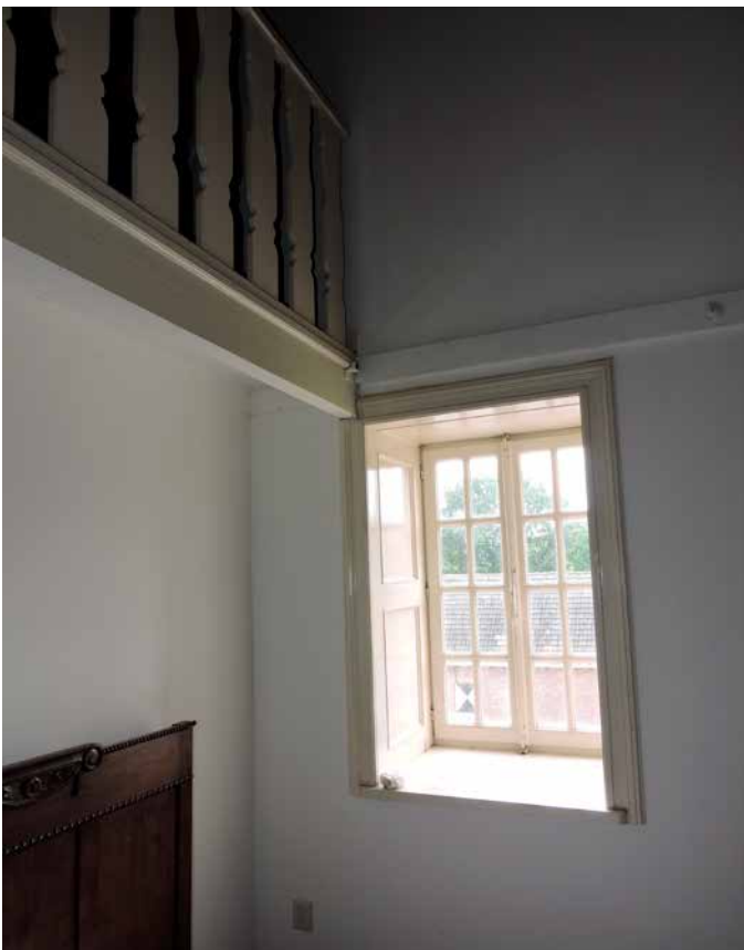
97. Raam op de verdieping aan de courzijde
