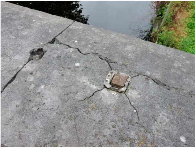
18. De bevestiging is klassiek met ingegoten en bijgeklopt lood
