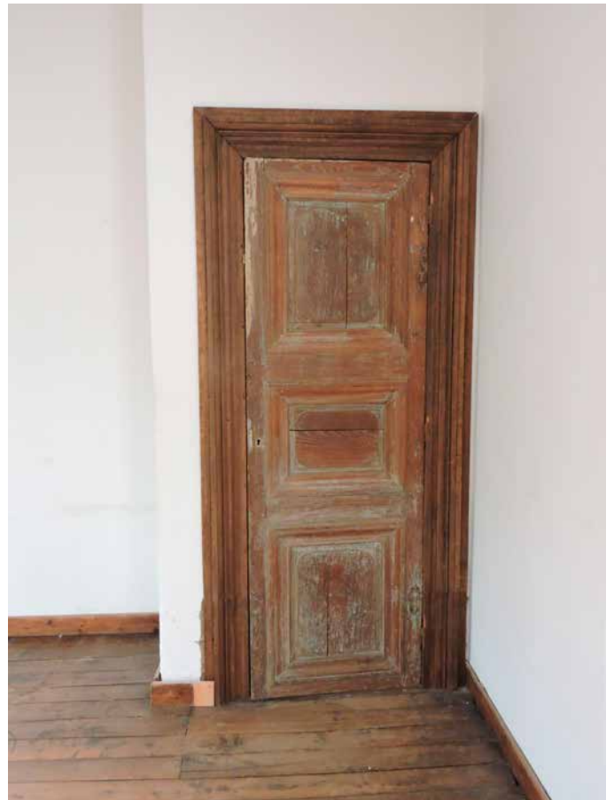
162. Daarbij zijn met oude deuren onder meer kasten gemaakt
