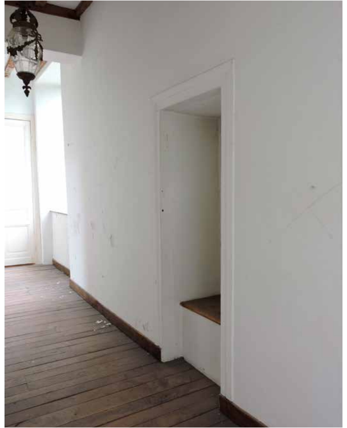
166. In de noordgevel zit een uitsparing die makkelijk de associatie met een muurtoilet kan oproepen. Waarschijnlijk gaat het om een nis waarin door personeel warm water voor de gebruiker van de slaapkamer er tegenover werd neergezet
