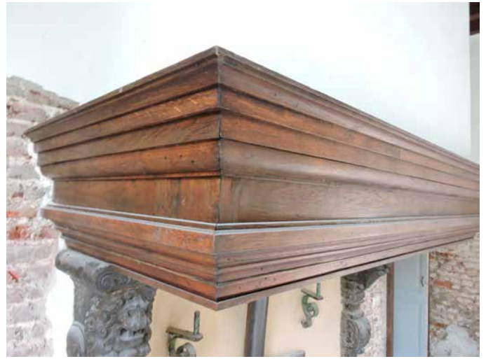
129. Het boezemhout is een optelsom van bestaande profielen maar is niet origineel en dus naar alle waarschijnlijkheid ook pas rond 1940 geplaatst
