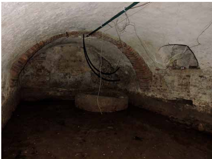
72. De derde kelder met een waterput, rechts een voormalige koekoek. De boog is een latere toevoeging om de druk van een nieuwe muur op de begane grond op te vangen
