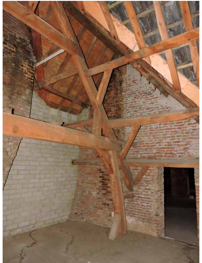
102. Aan de westkant is goed te zien dat de gordingkap oorspronkelijk een vrij dakvlak had, los van het dak van de vleugel van het herenhuis
