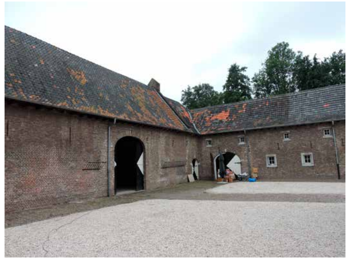
47. De rest van de stalvleugel, met links de schuur. Ook hier allemaal nieuwe openingen
