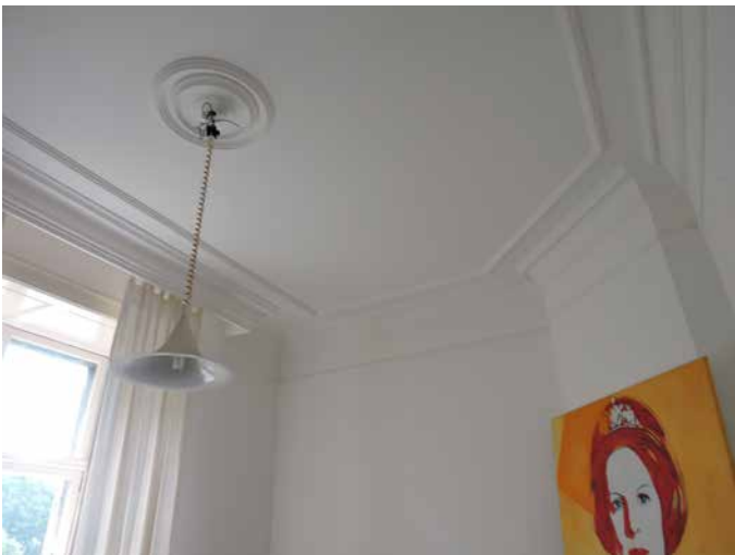
80. Delen van ouder lijstwerk zijn aangevuld met recente lijsten uit de bouwmarkt
