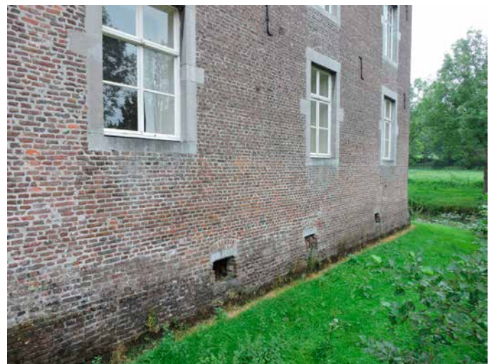
5. Rechts van de poort laat de gevel behalve diverse keldergaten de twee verdiepingen zien die zijn ontstaan na een verbouwing in de 18 de eeuw.
