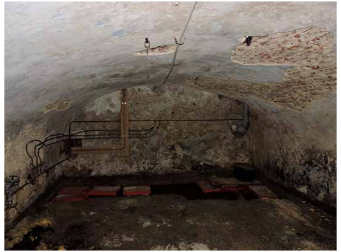
67. De eerste kelder heeft een bakstenen gewelf dat te dateren is inde late 18 de eeuw
