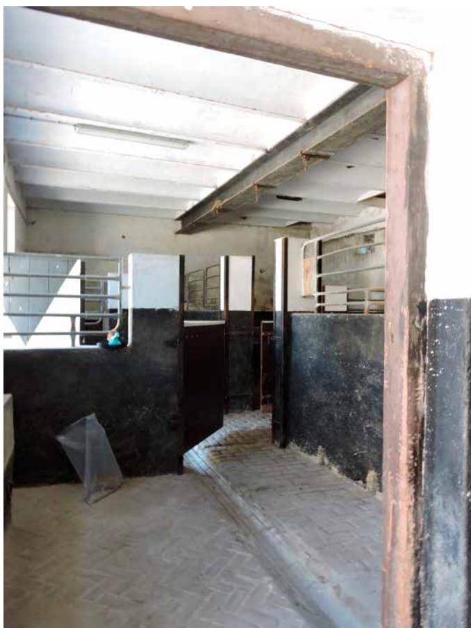
194. Een van de veulenstallen annex paardenstallen
