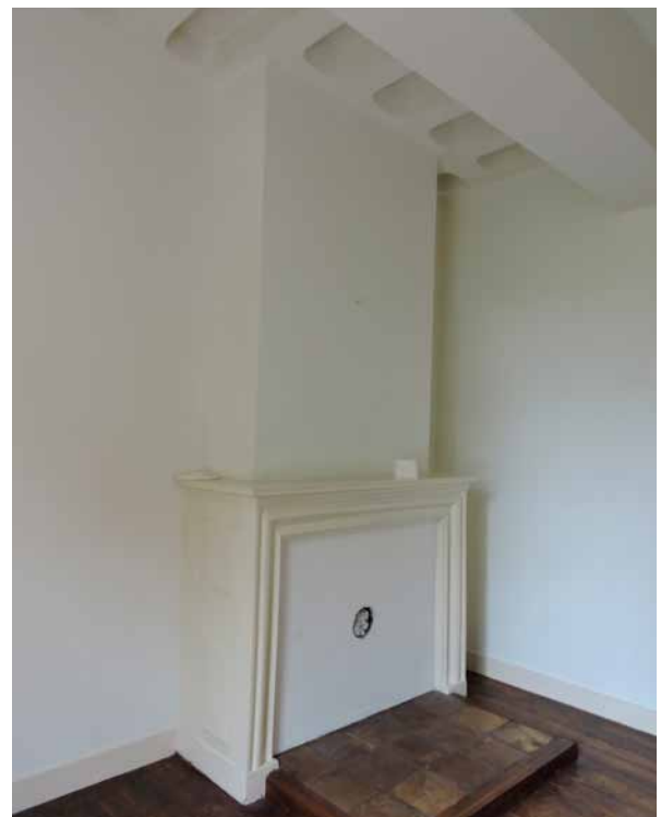
89. De plafonds zijn voorzien van Kölner Decken: geen klassieke speldering maar vlakke delen met afgeronde hoeken. De verschillende afstanden tussen de gewelven maken het aannemelijk dat de oude balklaag is gehandhaafd. Het pleisterwerk is vernieuwd
