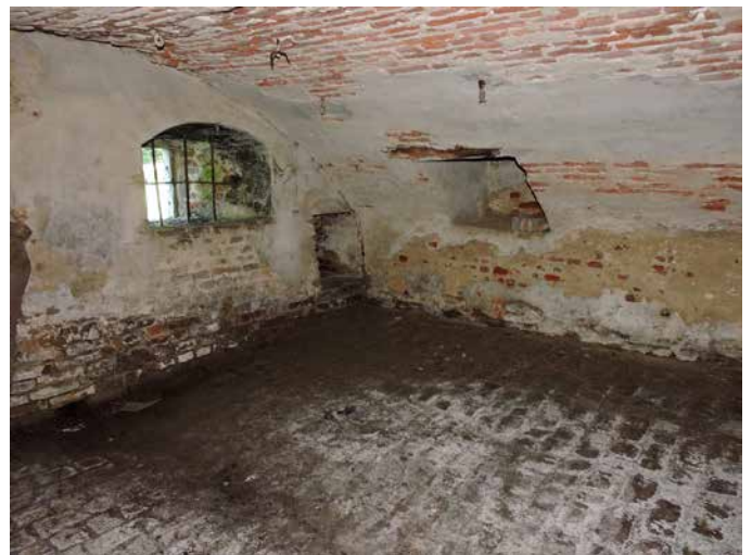
122. De andere kelder laat een identieke situatie zien. Omdat de lage nissen niet zichtbaar zijn dichtgemetseld is uitgesloten dat het vroegere openingen naar buiten zijn. de vloeren bestaan uit op hun platte kant gelegde bakstenen
