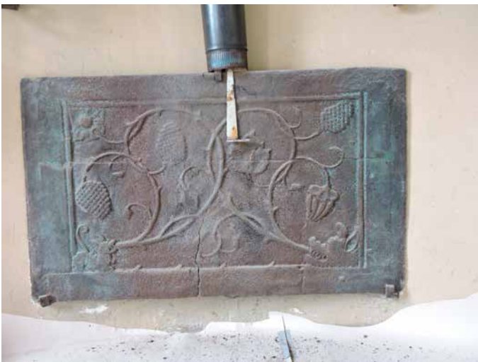
130. De renaissance haardplaat is niet origineel en is ook niet juist geplaatst
