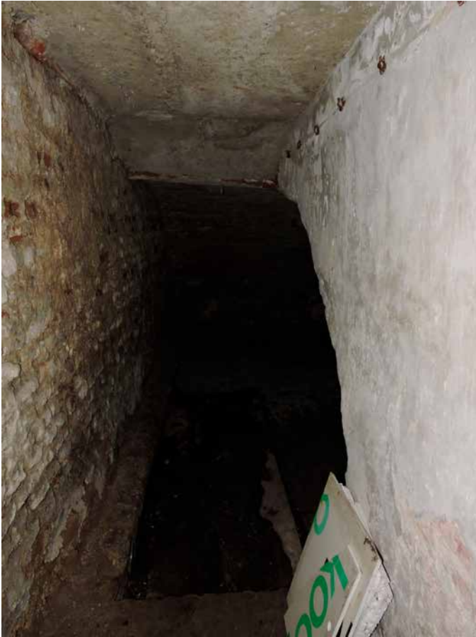
115. De verbinding naar rechts, waar twee kelders achter elkaar liggen
