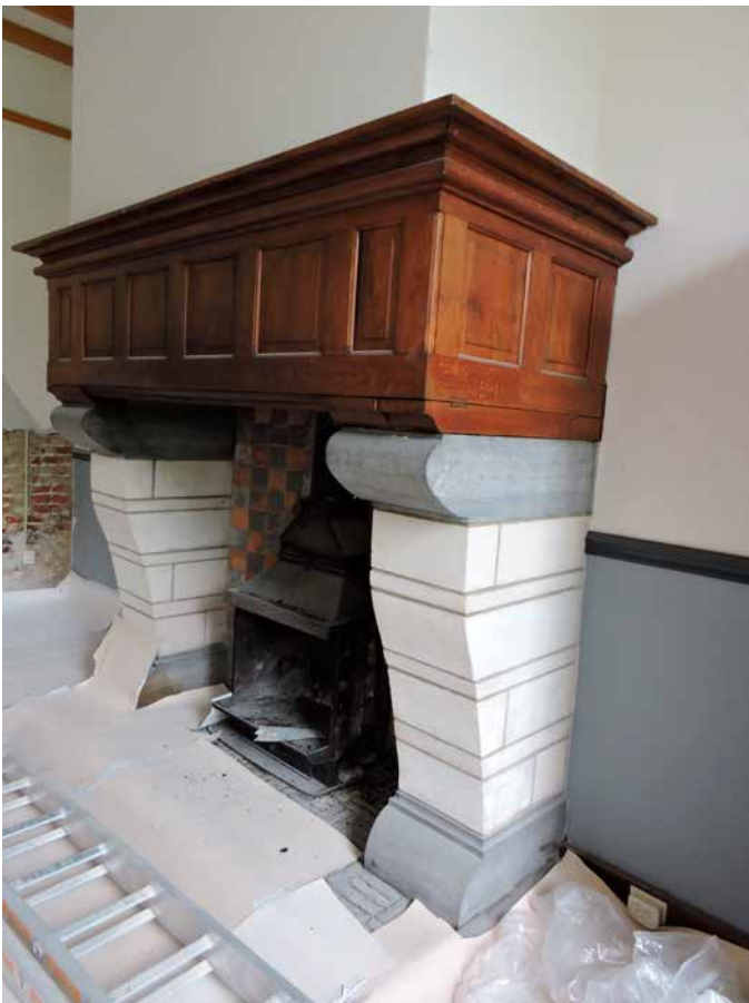
142. Die laat een merkwaardige vorm zien waarbij wel in de streek gebruikte materialen zijn toegepast
