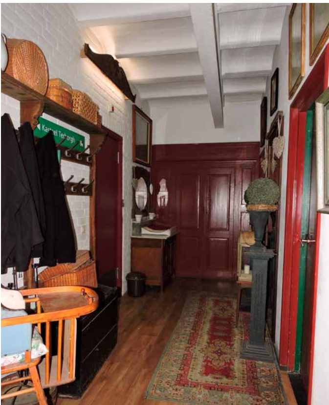
214. De ruimte inde schuur, met betonnen dek op ijzeren ribben, destijds de kalverstal en veekeuken
