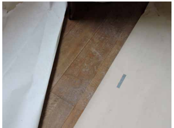
151. Detail van de vloer op de verdieping met nieuwe eiken planken
