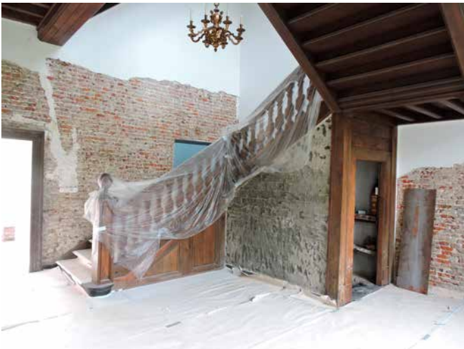
113. Onder de trap ligt de ingang van de kelders
