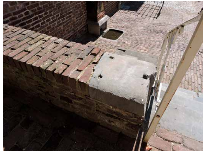
35. De muurtjes van het terras zijn bij de opgang naar de voordeur afgedekt met stukken steen van de brugleuning
