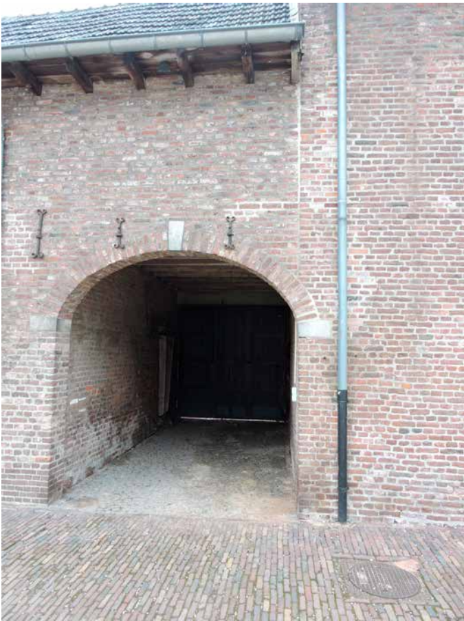
46. De poortdoorgang naar het buitenterrein annex het motte-eiland heeft aan de binnenplaatskant geen houten poort. Het muurwerk is helemaal nieuw
