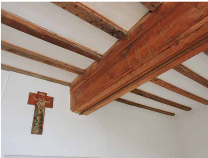
167. Een van de slaapkamers met opnieuw een omtimmerde moerbalk, hergebruikte kinderbalkjes en een nieuw plafond
