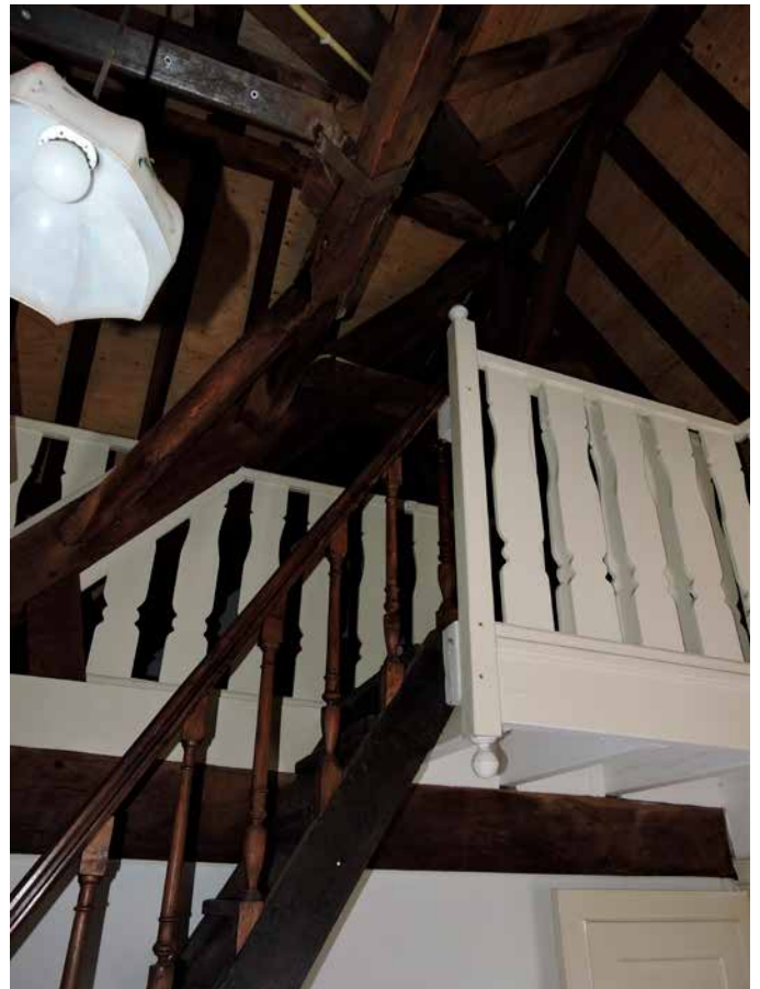
96. Een optelsom van trapdelen tot in de nok. Het spantwerk is origineel
