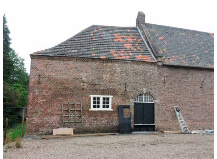
21. De invulling van dit deel is secundair, staat tegen de kopgevel van de schuur aan de zuidkant en is m.n. door de twee dakschilden te herkennen als extra toevoeging. Opvallend is de muizentandversiering onder de dakrand
