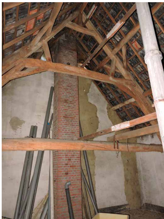
195. De kap van de hele vleugel is origineel. Deze is vroeg-19de eeuw, volgt grosso modo het principe van de 18 de eeuwse kappen van het huis, maar is lichter van uitvoering
