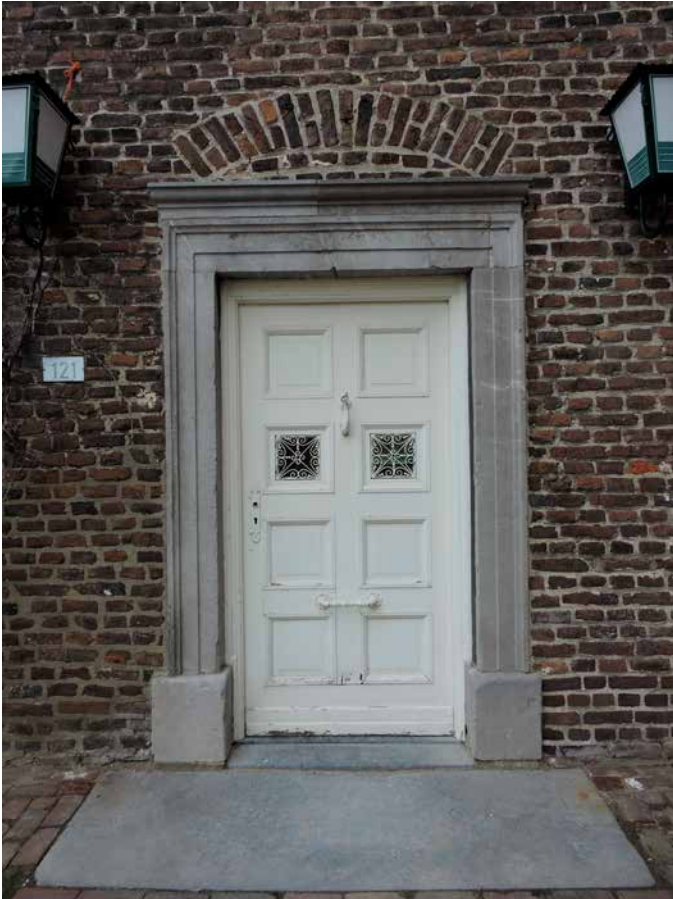
34. Ook hier is te zien dat de omlijsting later is ingepast in bestaand metselwerk
