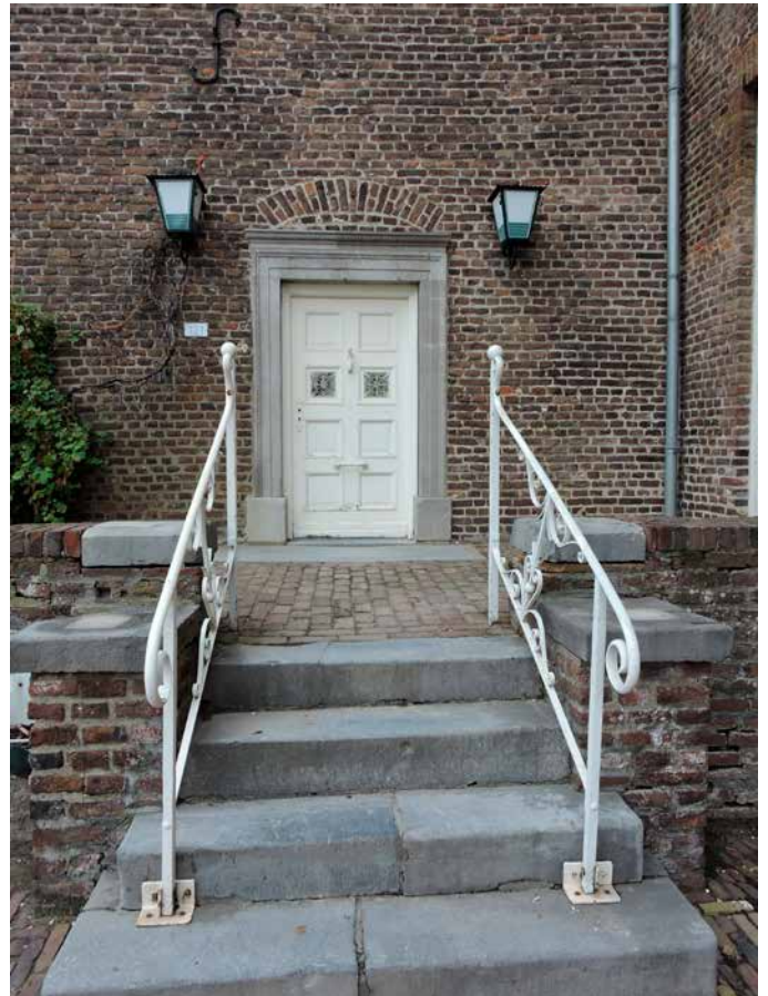
33. De voordeur heeft een omlijsting van Naamse steen en is te dateren rond 1800. De deur zelf is secundair
