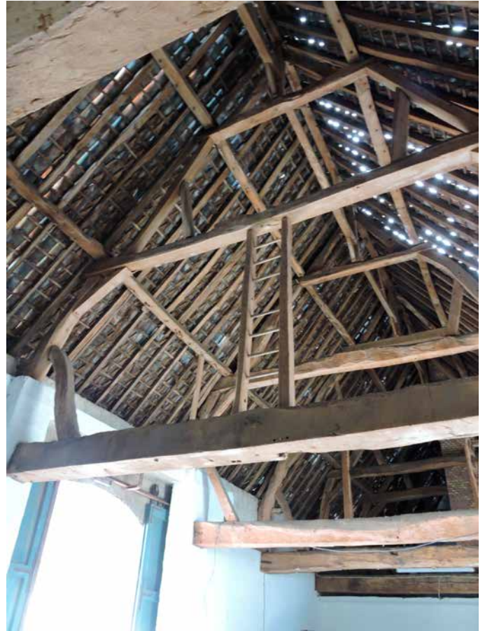
209. Spant met deel van een oogstladder, rechts van de doorgang naar de cour
