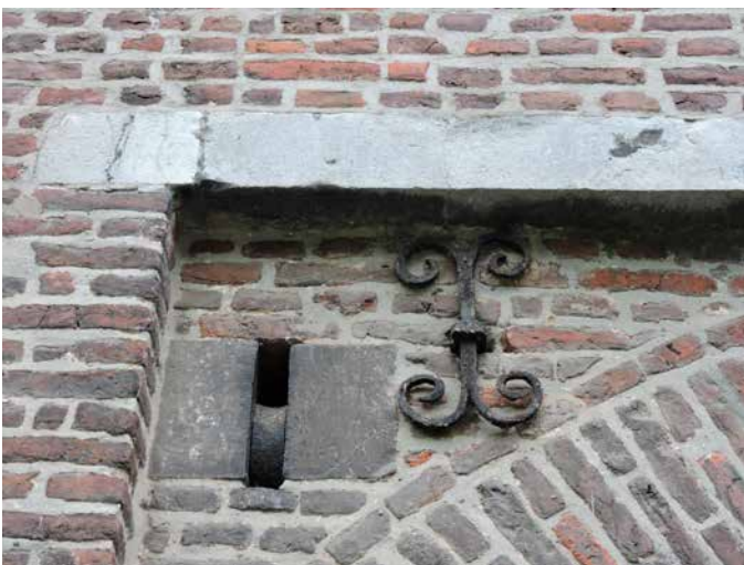
4. Dat ophalen geschiedde door aan de binnenkant met een haspel of balken met een contragewicht het hele brugdek op te takelen waarbij dat aan de voet van de poort scharnierde. De katrollen maken dat proces goed zichtbaar. Het brugdek zelf viel in het verdiepte deel van de gevel
