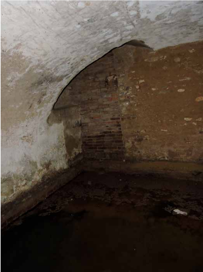
74. De middelste kelder is korter en had aanvankelijk een entree van binnenuit. De muur heeft te maken met latere scheidingsmuren op de begane grond
