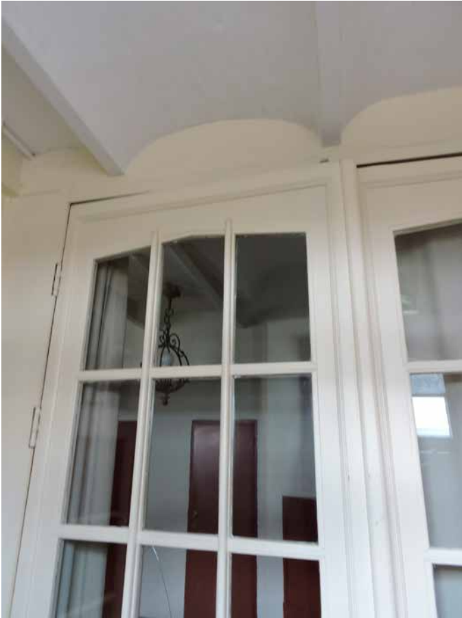
223. De voordeur vanaf de binnenplaats aan de binnenzijde, gevolgd door een tochtportaal met glasdeuren. De plafonds bestaan uit gegoten betonnen elementen die een gespelderd plafond imiteren
