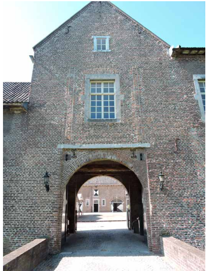
3. De sporen daarvan zijn duidelijk waarneembaar in de vorm van de boven de poortdoorgang aanwezige verticale, dicht-gemetselde sleuven waarin de bomen die horizontaal liepen met het brugdek en daaraan verbonden waren door kettingen opgesloten werden als de brug was opgehaald
