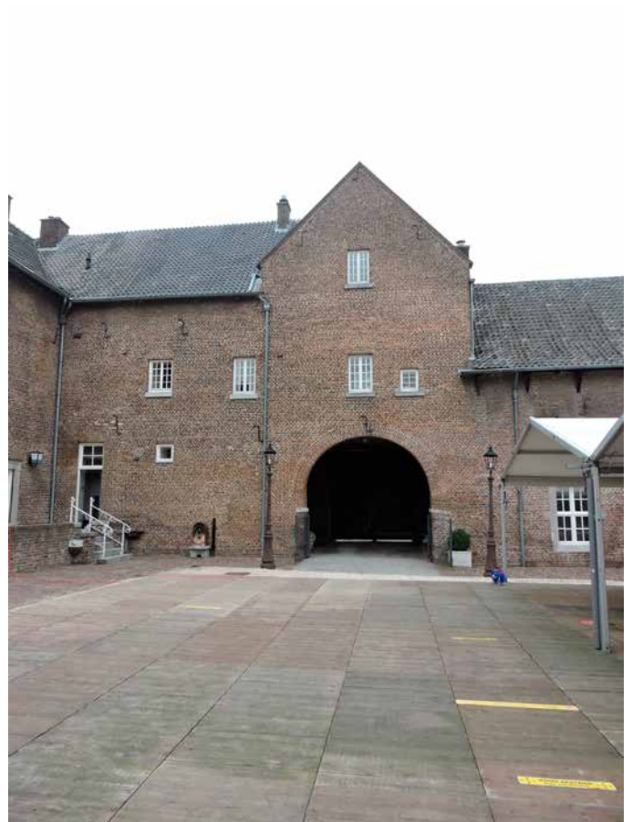
29. Het poortgebouw aan de binnenzijde. Rechts de oorspronkelijke hoogte van de aansluitende vleugels, links is die in de 18 de eeuw opgehoogd. Opvallend is de willekeurige plaatsing van openingen, waarbij de zeer smalle deur helemaal links, nu de dagentree van het herenhuis, pas in 1993 is aangebracht
