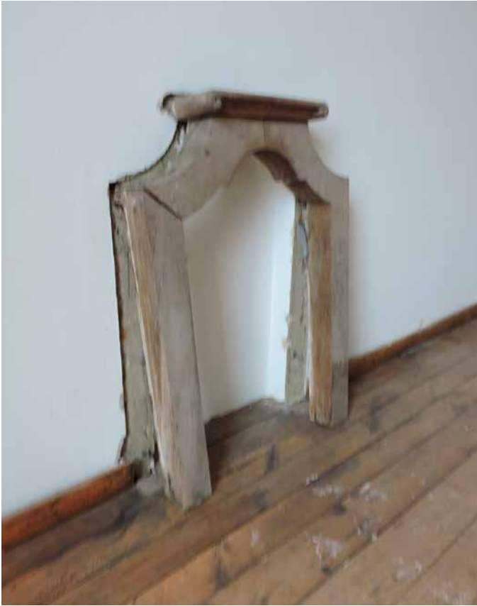
165. Een van de rudimentaire haardlijsten, bedoeld om er een versierde plank aan te bevestigen. Het is de vraag of er ooit op deze plek een haardje was
