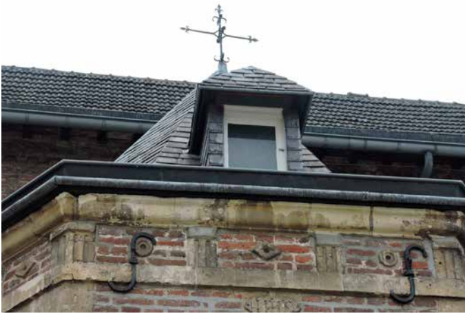
38. De lijst bestaat uit trigliefen en rondjes van mergel, afgewisseld met liggende ruitvormen. Het dak van de kapel is gedekt met leien, alle andere daken hebben zwarte muldenpannen. Alleen de schuurvleugel heeft Vlaamse pannen, zwarte en rode
