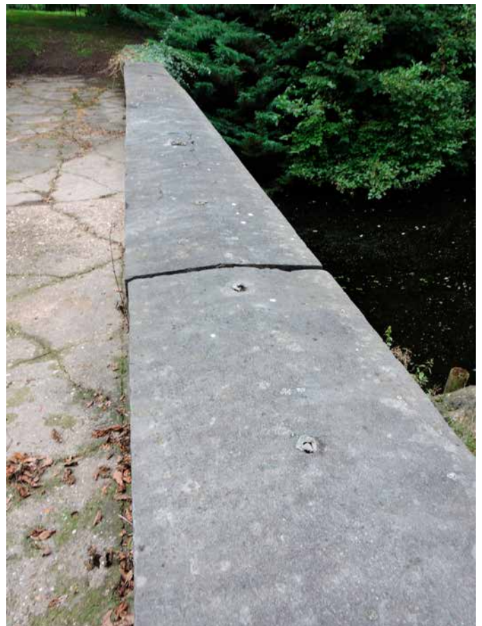
17. In de platen zijn de restanten van hekwerk te zien dat afgezaagd is
