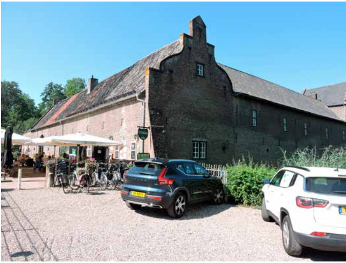
26. De oostkant, met helemaal rechts het poortgebouw
