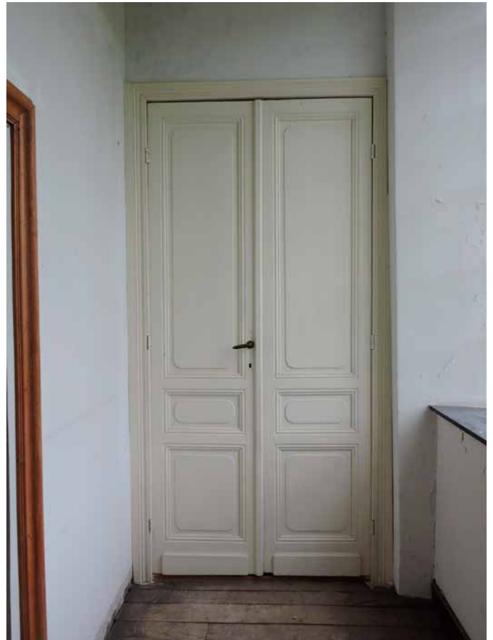
164. Op de kop van de gang is een muurkast gemaakt. Ook hier hergebruikte deuren
