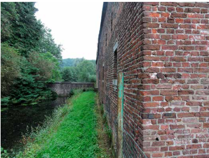
20. De achterkant tot aan de zuid-westhoek
