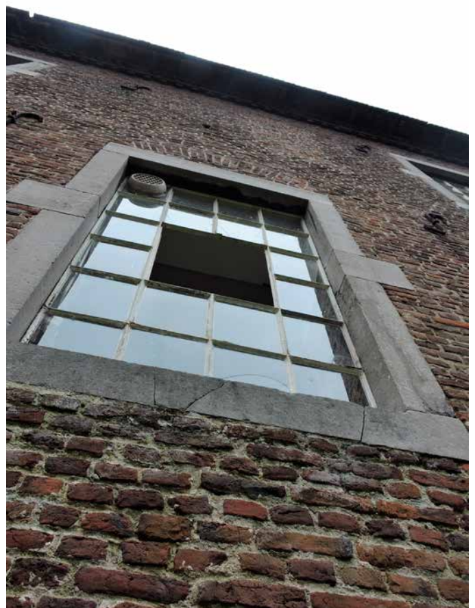
9. Kenmerkend voor de ijzeren ramen is het centrale deel dat open kan, analoog aan industriële ramen van rond 1900
