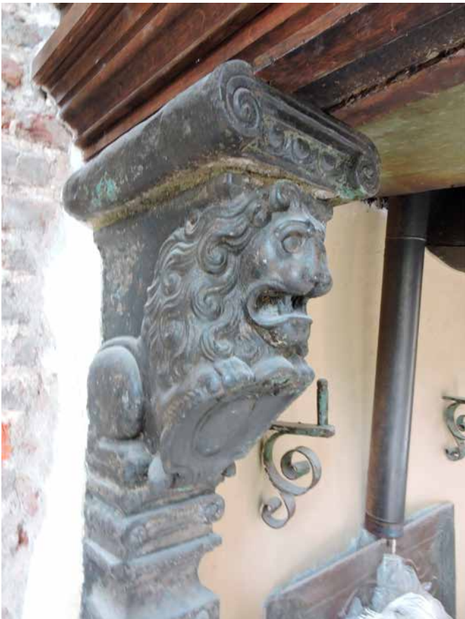
126. De haardwangen zijn typerend voor de vroege 17 de eeuw. De krul van de haardband is nieuw wat de vraag oproept of beide ophanghaken niet vernieuwd zijn
