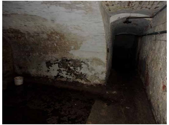
71. De verspringing in het plafond van de verbindende gang laat zien dat de kelders separaat van elkaar zijn gemaakt
