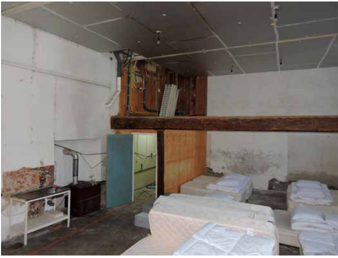
180. De aansluitende ruimte achter de poort, in gebruik geweest als kunstenaarsatelier
