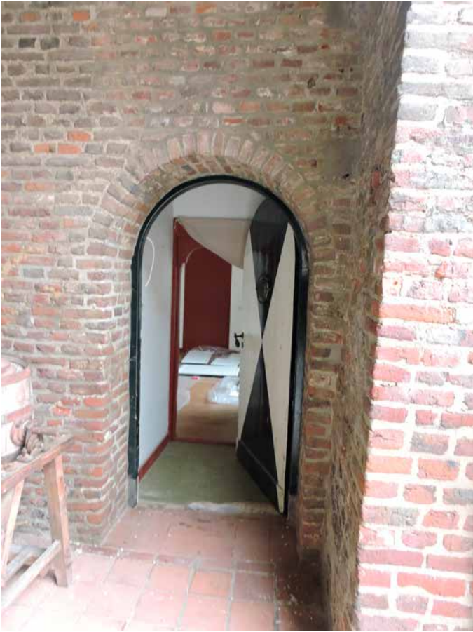
218. De entree naar de sterk aangepaste woning links van de poortdoorgang
