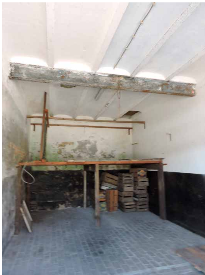
193. De bijbehorende ruimte. Alle plafonds hebben ijzeren ribben en een betonnen dek
