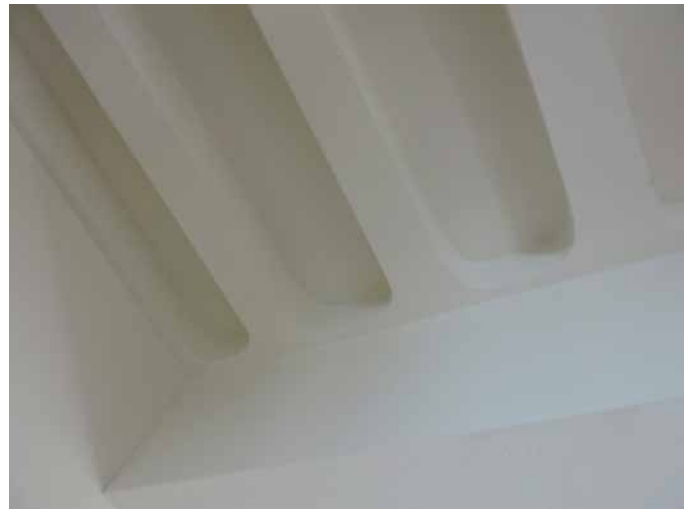
89. De plafonds zijn voorzien van Kölner Decken: geen klassieke speldering maar vlakke delen met afgeronde hoeken. De verschillende afstanden tussen de gewelven maken het aannemelijk dat de oude balklaag is gehandhaafd. Het pleisterwerk is vernieuwd
