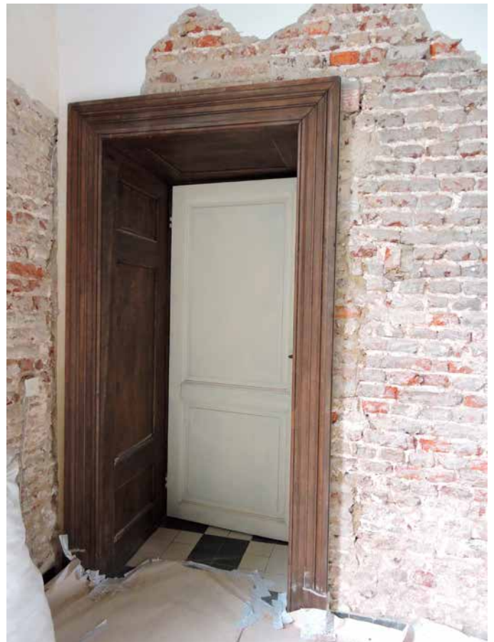
131. De deur links van de haard geeft goed de dikte van de topgevel aan van het oorspronkelijke huis. Een haard tegen een topgevel is niet gebruikelijk, opnieuw een argument voor een historische herplaatsing van de haard
