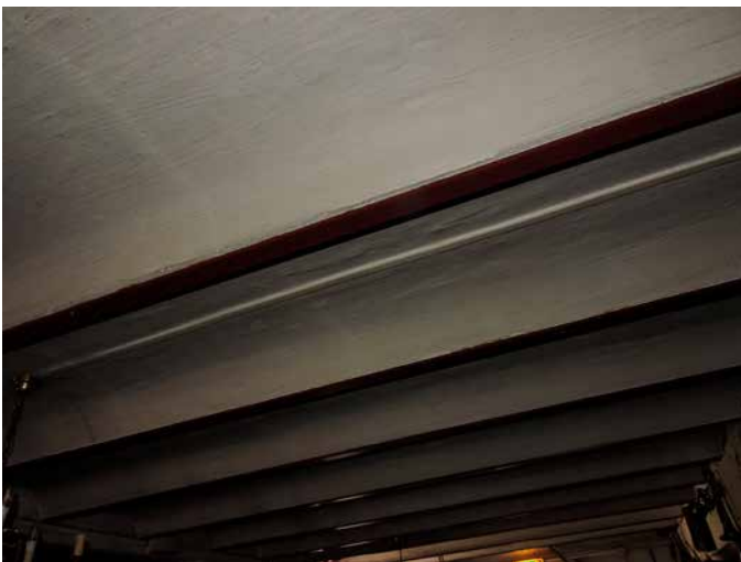
214. De ruimte inde schuur, met betonnen dek op ijzeren ribben, destijds de kalverstal en veekeuken
