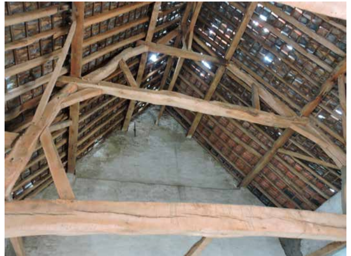
211. Het flieringspant links van de doorgang
