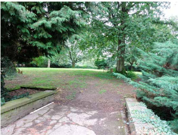
16. De brug was aan beide zijden afgedekt met platen Naamse steen. Rechts is die nog aanwezig, links is her en der hergebruikt
