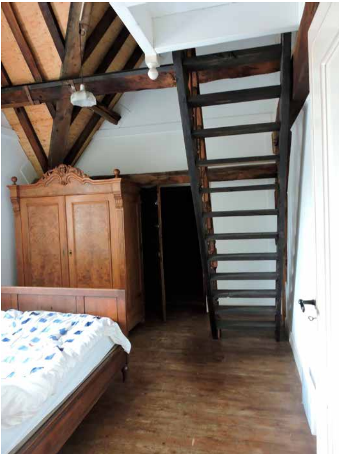
95. De kamer boven de poort, met doorkijk naar de zolder van de rechter vleugel. Het dak van beide delen kapt met een kil op elkaar aan
