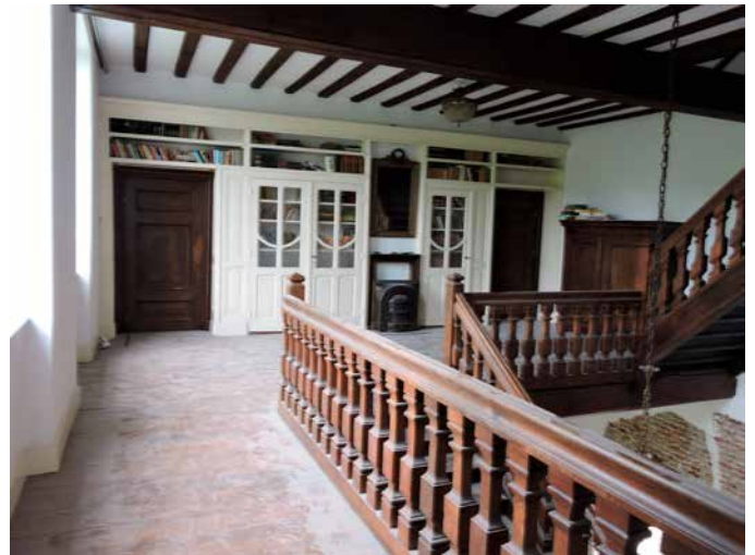
155. Blik vanuit het begin van de gang langs de noordgevel die de slaapkamers ontsluit
