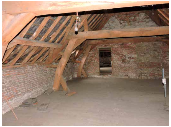
170. Blik richting noord-oosten, met doorkijk naar de haakse vleugel, rechts van de poort
