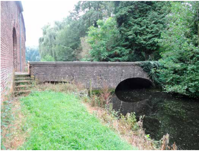
14. De stalvleugel eindigt bij de poortonderdoorgang vanuit de binnenplaats naar het motte-eiland, met de gemetselde brug die in de 19 de eeuw te dateren is
