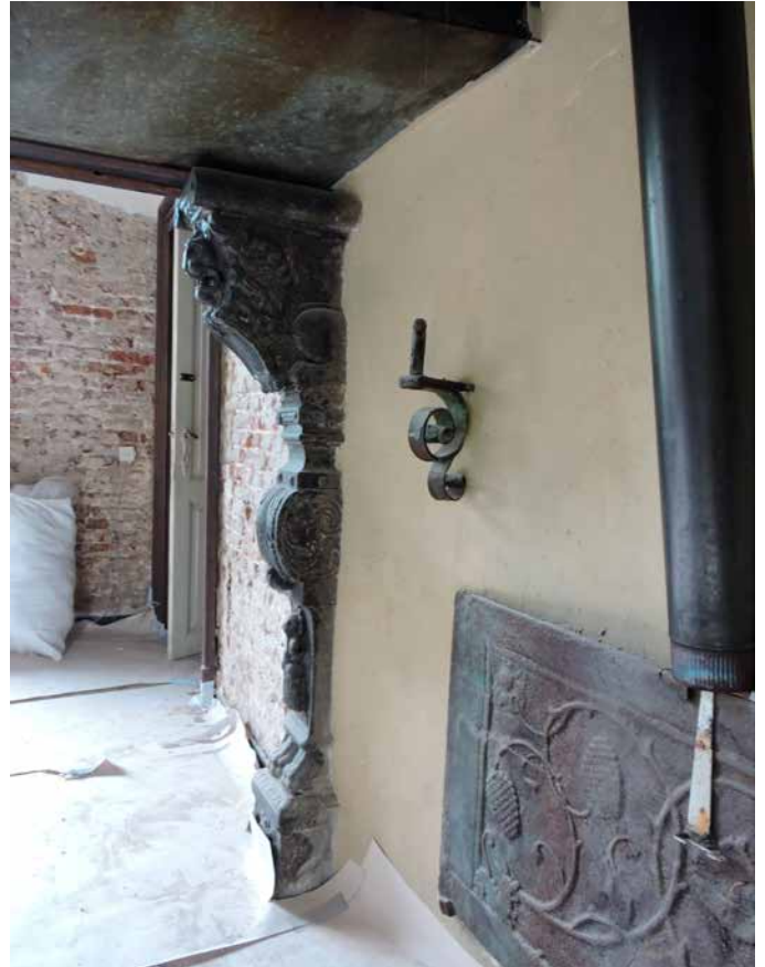
125. De haard in profiel. De samenstelling klopt net niet wat de mogelijkheid dat de haard in zijn geheel een nieuw element is verhoogt
