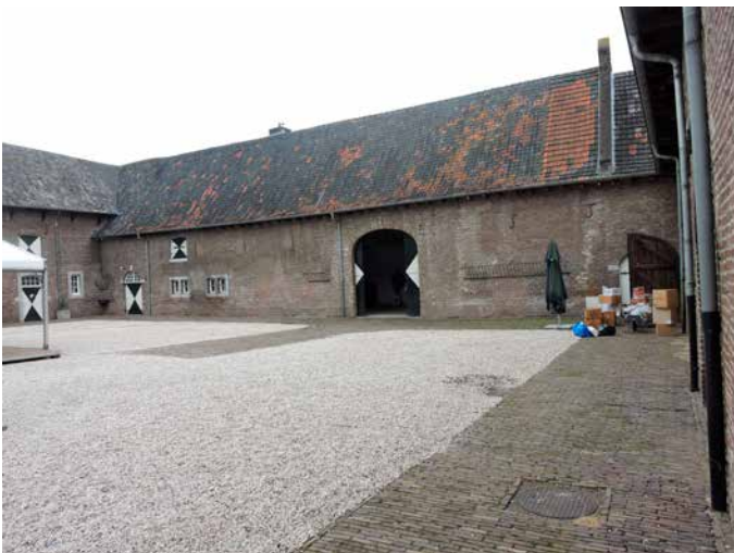
48. De schuur met aansluiting, links, op de stalvleugel in de poortvleugel
