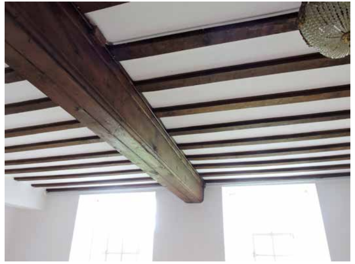
158. De kinderbalkjes zijn nieuw, de moerbalk is omtimmerd met eiken planken. Het is niet duidelijk of die ijzeren balken omsluiten of oorspronkelijke balken die geen mooie volle en strakke maat meer hadden
