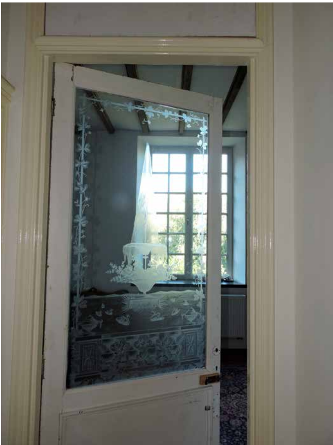
186. Hergebruikte deur met geëtst glas op de verdieping
