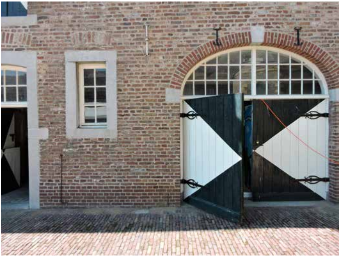
50. De poort in de schuurvleugel vervangt een ouder exemplaar
