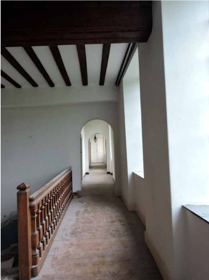
157. De gang langs de noordgevel
