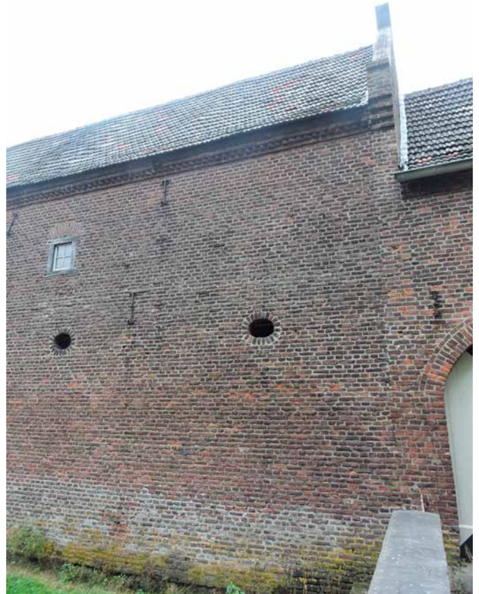
19. De poortdoorgang ligt net naast de stalvleugel. Aan de binnenplaatskant is te zien dat dat deel daar opnieuw is opgemetseld.
