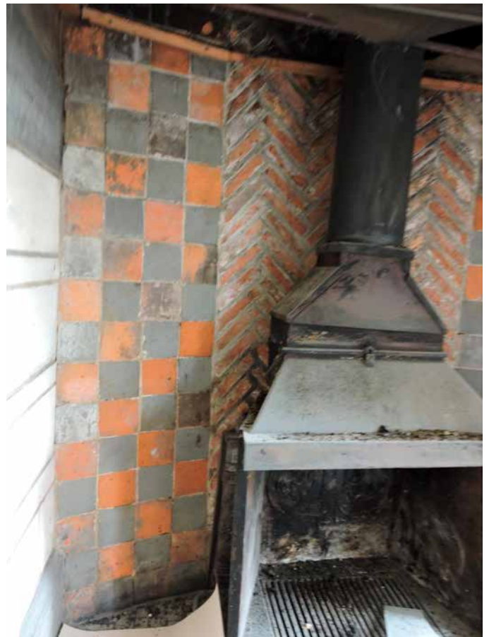
143. Voor de vuurplaats zijn oudere stookvloertegeltjes gebruikt op een zeer ongebruikelijke manier. Gezien de herkomst van het ontwerp een merkwaardige oplossing
