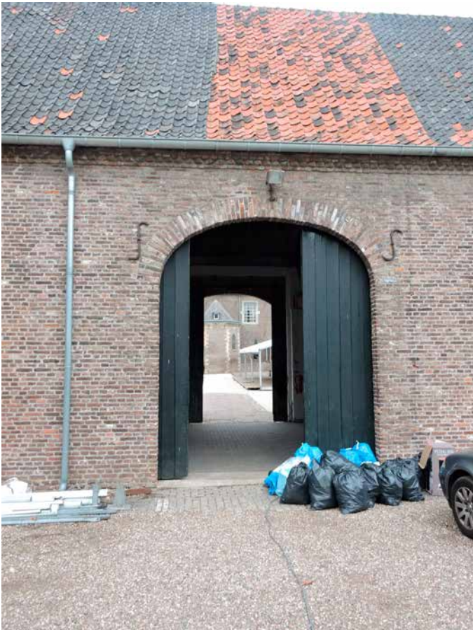
24. Ook hier een muizentandlijst. De poort was aanvankelijk een vierkante opening maar is rond 1940 opgewaardeerd tot de huidige vorm
