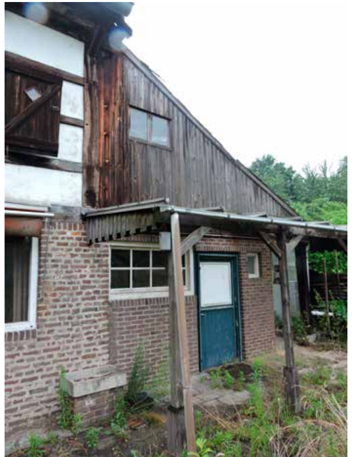
10. Aanbouw met annexen aan de oostkant, uit 1939
