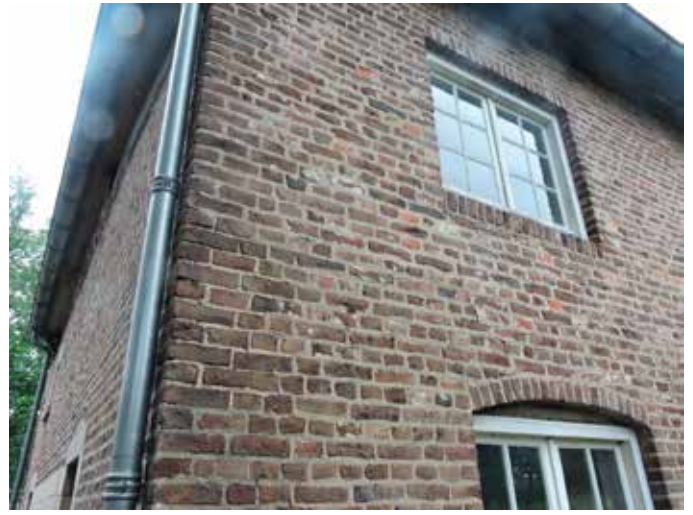
4. Het metselwerk op de hoek van zuid- en westgevel; de gebruikte steen en het toegepaste metselverband, plus de gebruikte specie maken duidelijk dat de hoek van de gevel in 1939 grotendeels opnieuw is opgetrokken. Midden 19 de eeuw werd er al een muur voor het vakwerk van de zuidgevel gezet.
