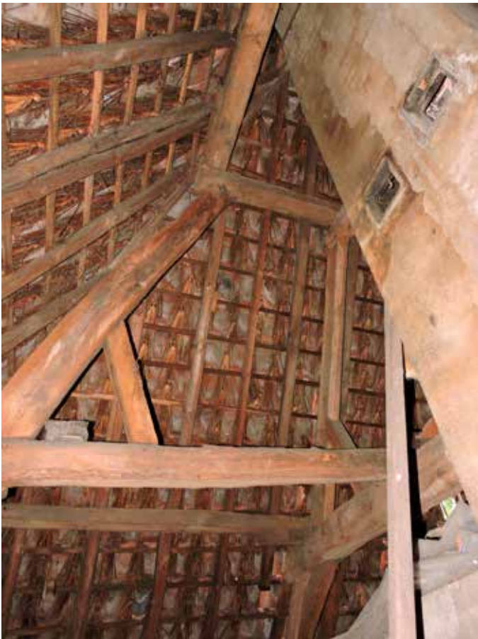
56. Een halfspant van opzij gezien
