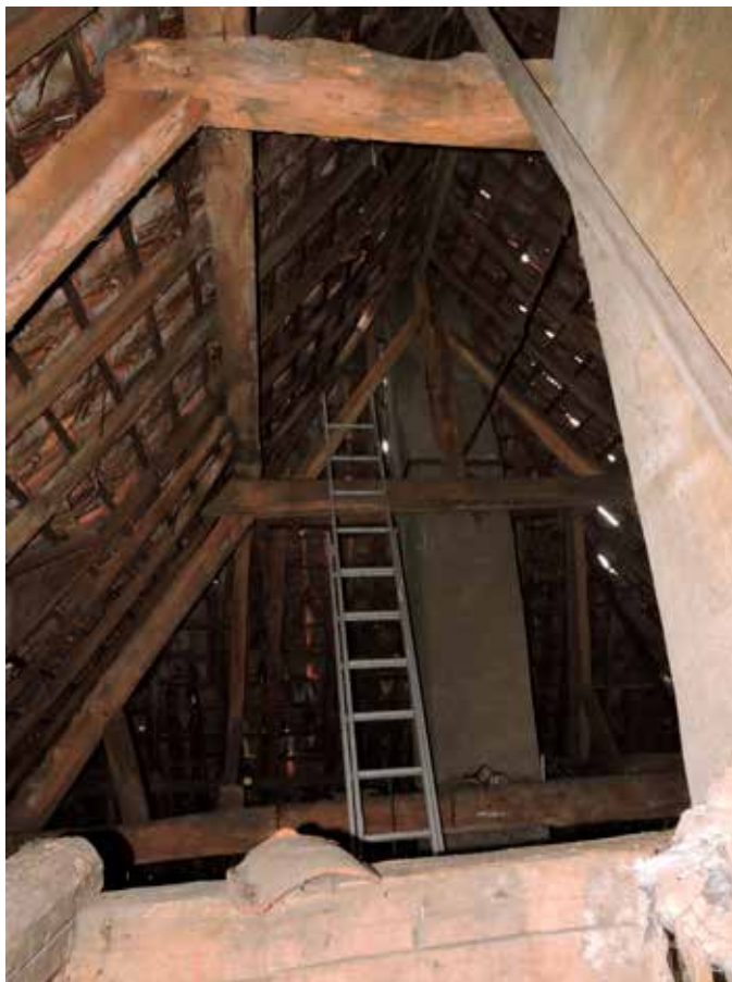
54. De kap naar de westkant gezien. De schilden kappen aan met halfspanten die rusten op de jukdebalken van de hoofdspanten die parallel staan aan de smalle zijden van het pand
