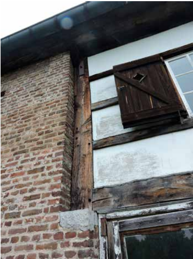
7. De toognagelgaten aan de linkerkant in de stijl verwijzen naar vroegere houtverbindingen van het vakwerk
