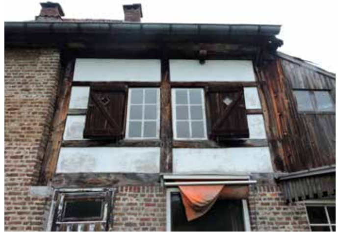
8. Het restant vakwerk is origineel, de ramen zijn secundair, ook gezien de doorbroken regel halverwege de ramen
