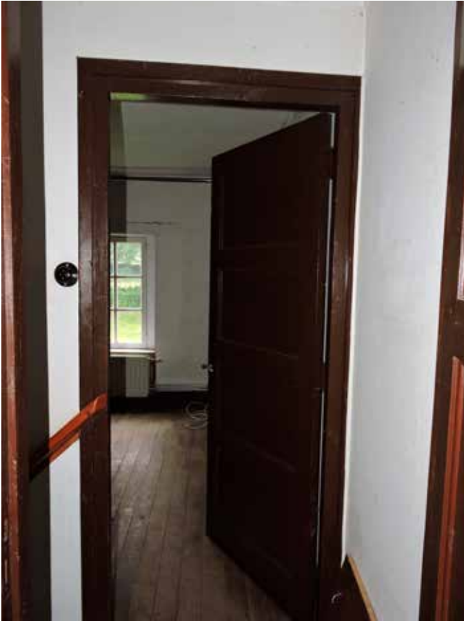
43. .... waar inpandig een verbinding bestaat met het achterste stuk van het huis dat een secundaire eigen trap naar boven heeft gekregen nadat dat stuk een separate woning werd, rond 1960. Oorspronkelijk was dit deel, achter de huidige tuindeuren, een berging
