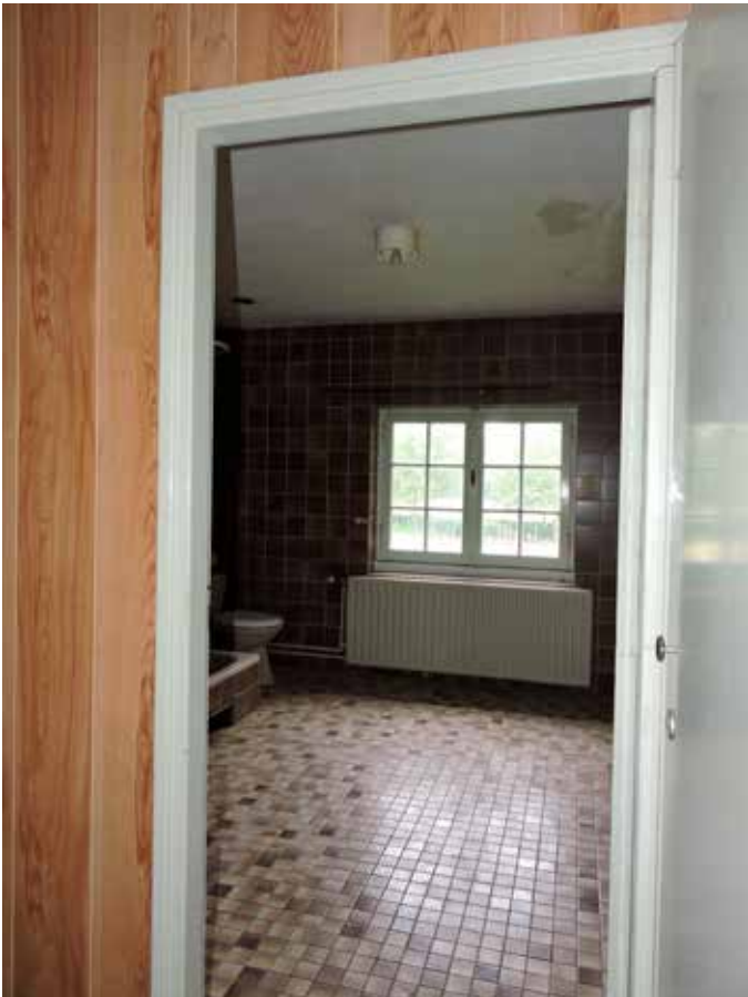
41. De latere badkamer, te dateren rond 1970, waarvoor de vloer is opgehoogd
