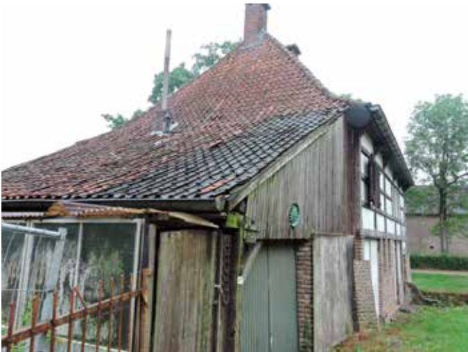
15. Latere aanbouwsels aan de oostkant, tegen het aanvankelijk open gedeelte uit 1939, waarbij alle daken zijn gedekt met Vlaamse pannen
