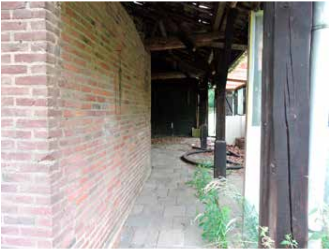
11. De kolommen en het afdak dateren eveneens uit 1939
