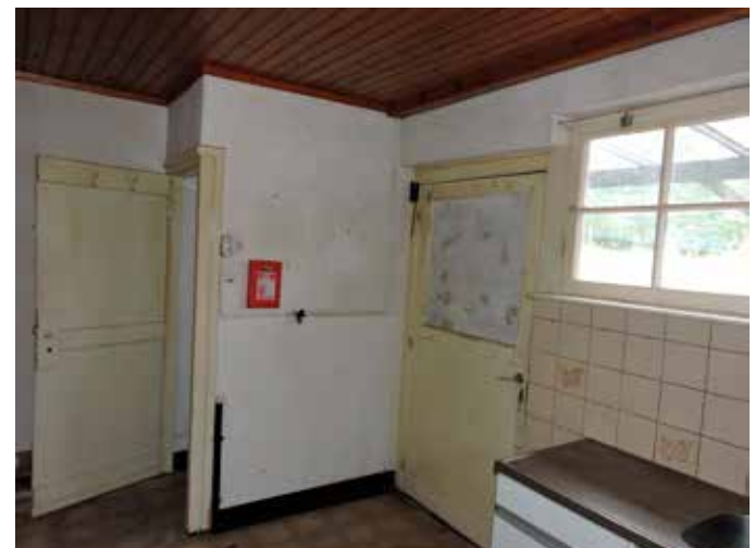
47. De ruimte achter de tuindeuren, links in de noordgevel
