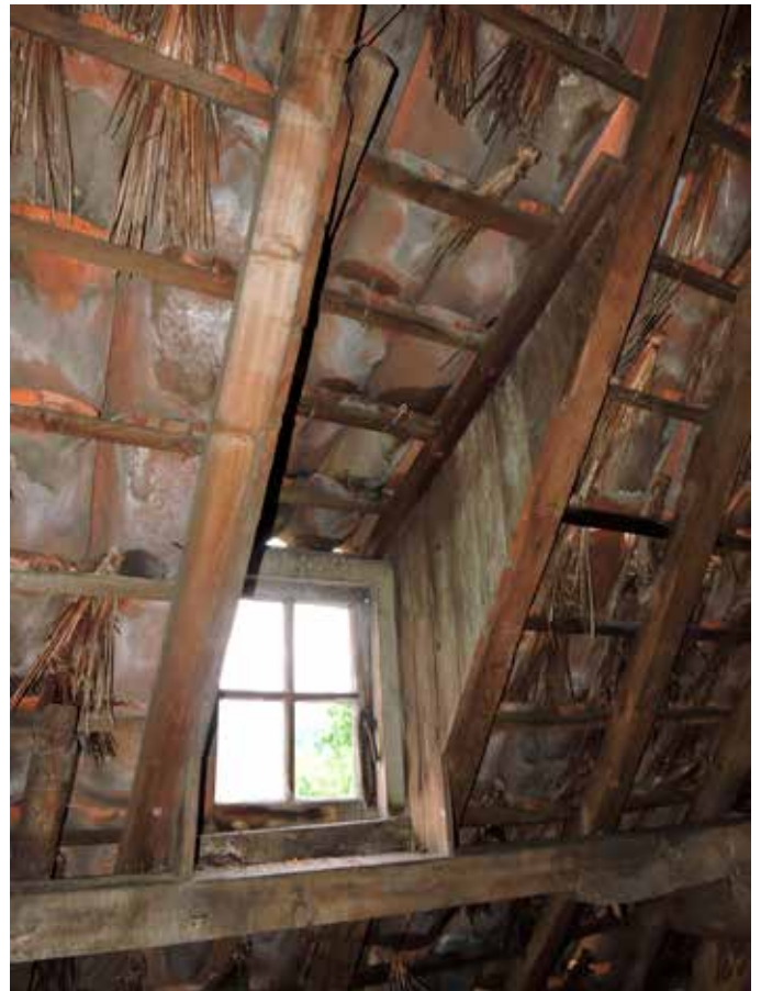
57. De dakkapellen in de dakvlakken aan de noord- en de zuidzijde zijn secundair en aangebracht bij de campagne van 1939
