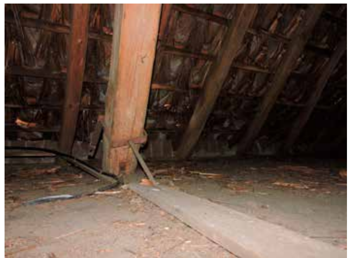
59. De jukbenen zijn met beugels verankerd aan de onderliggende moerbalken
