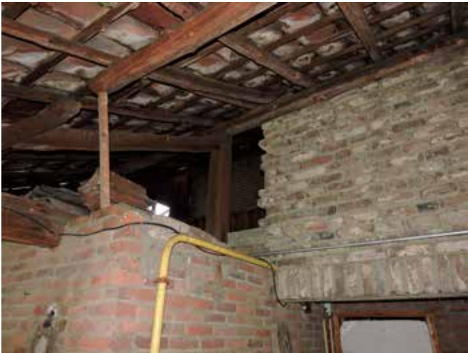
13. Doorkijk langs de aanbouw uit 1939, en de recente aanbouw naar de nieuwe achtergevel van het molengebouw
