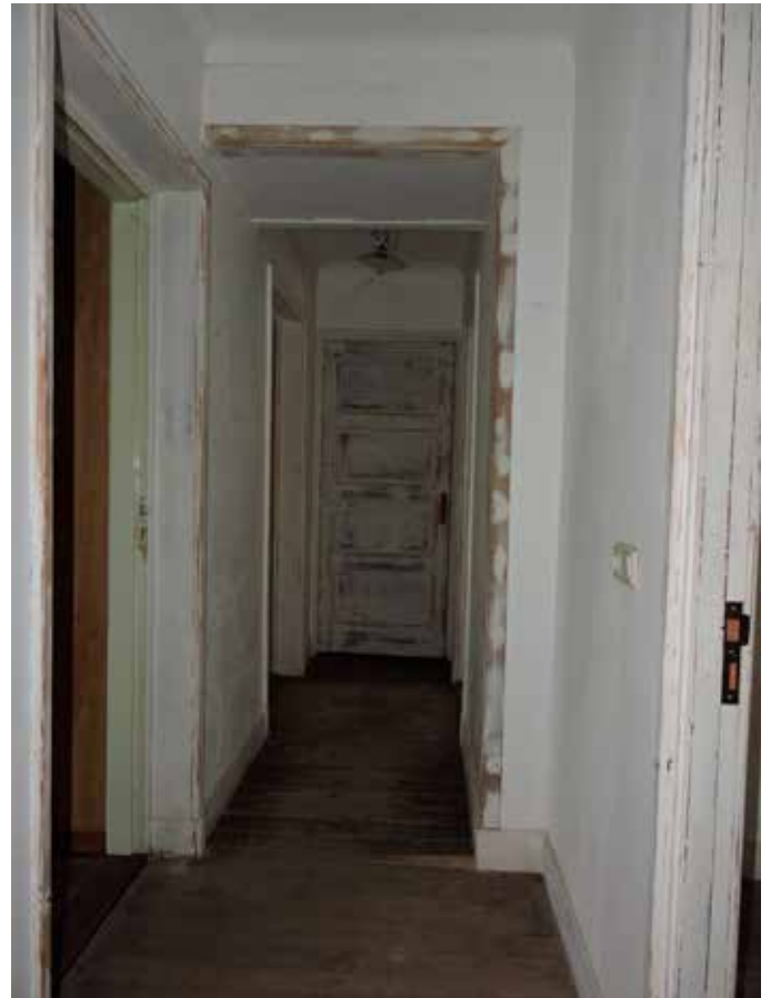
38. De kamers op de verdieping ademen in alles de sfeer van de bouwtijd, 1939, inclusief de deuren met hun liggende panelen in triplex
