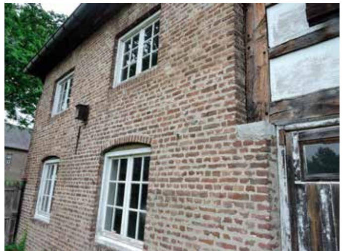
6. De verspringing van de muur naar het terugliggende vakwerk maakt duidelijk dat de muur voor het vakwerk is gezet.
