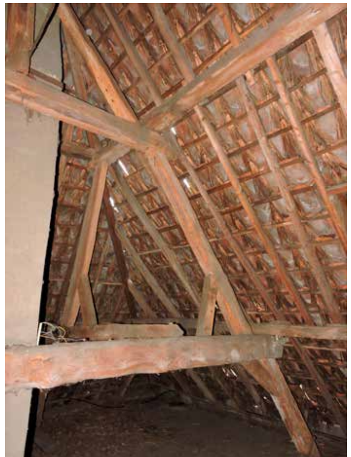
55. De kap, met een goed doordachte constructie, is uit de bouwtijd, de 18 de eeuw. Hier gezien naar de noord-west-hoek
